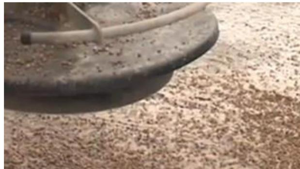
**Рис. 17. Посыпание дорог гранитной крошкой. Источник: 1.**
